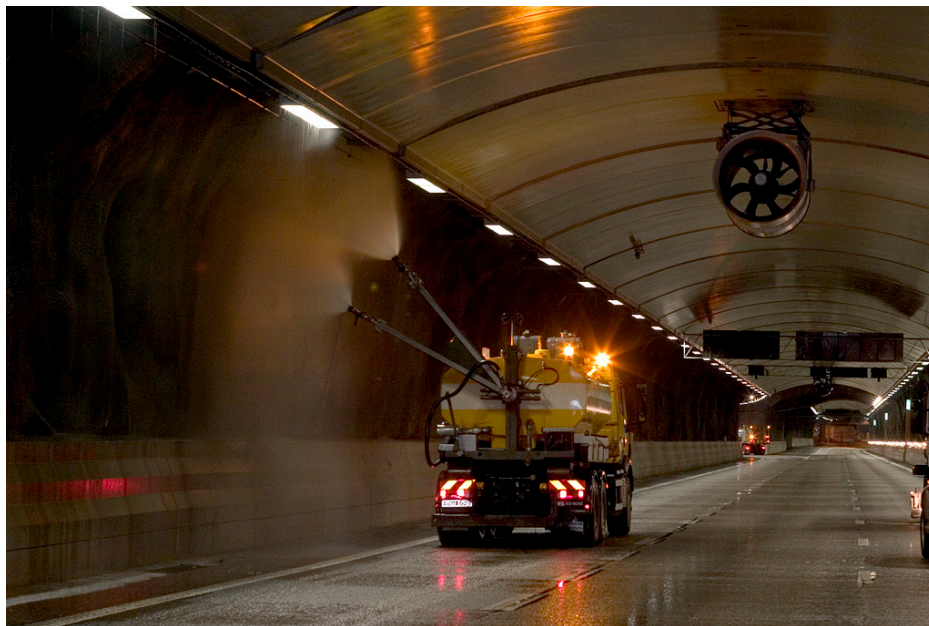
Figur 1. Mobil utrustning för tunneltvätt (foto R. Pettersson, Svevia)
